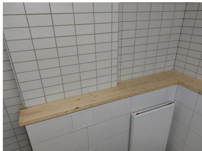
In der gründlichen Planung lag der Beginn unserer Arbeit. Wir nahmen das Maß der abzudeckenden Wandecke der Vorwandinstallation und übertrugen diese auf eine 3-Schicht-Platte aus Fichtenholz. Nach dem Anreißen konnten wir die Bretter mithilfe der Formatkreissäge zurechtsägen. Die Dickenhobelmaschine half uns, alle Bauteile auf eine einheitliche sowie gleichmäßige Dicke zu bringen.
