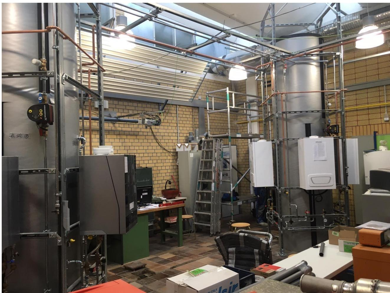
Smart Home hält Einzug. Die Umbauarbeiten in dem Heizungslabor an der BS I liegen in den letzten Zügen. Mit dem Umbau wird der praktische Bereich um 4 Gasgeräte der Firma Buderus und 4 Gasgeräte der Firma Brötje erweitert. Damit haben alle Schüler während der praktischen Ausbildungsphase die Möglichkeit selbstständig an den Geräten Wartungs- und Inbetriebnahmearbeiten durchzuführen.
