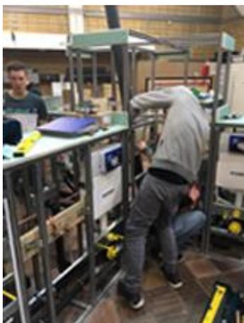
Smart Home hält Einzug. Die Umbauarbeiten in dem Heizungslabor an der BS I liegen in den letzten Zügen. Mit dem Umbau wird der praktische Bereich um 4 Gasgeräte der Firma Buderus und 4 Gasgeräte der Firma Brötje erweitert. Damit haben alle Schüler während der praktischen Ausbildungsphase die Möglichkeit selbstständig an den Geräten Wartungs- und Inbetriebnahmearbeiten durchzuführen.
