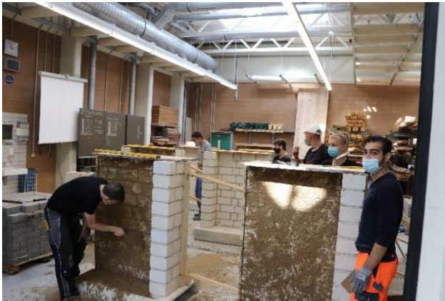
Abteilung Bautechnik (Ausbildungsinhalt: Spritzbewurf)
