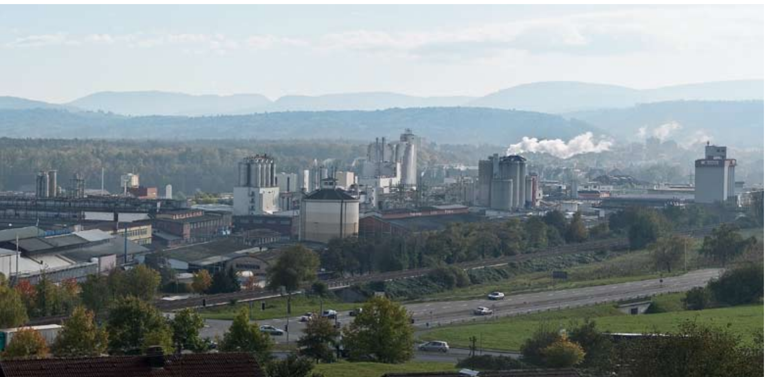
Panoramaansicht des gesamten Komplexes
